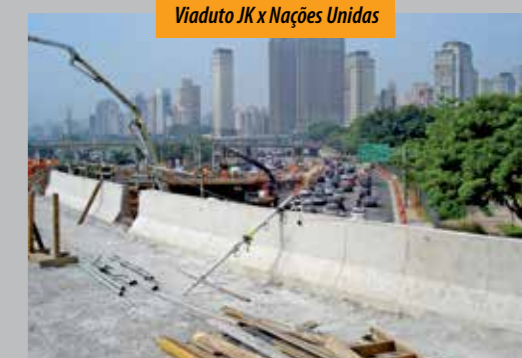
Viaduto JK x Nações Unidas
