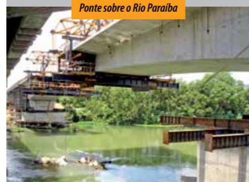
Ponte sobre o Rio Paraíba
