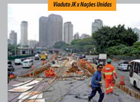
Viaduto JK x Nações Unidas
