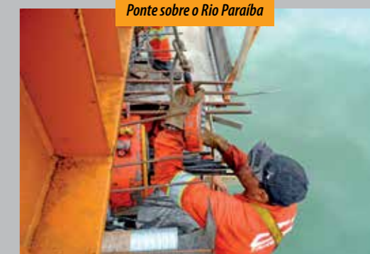
Ponte sobre o Rio Paraíba
