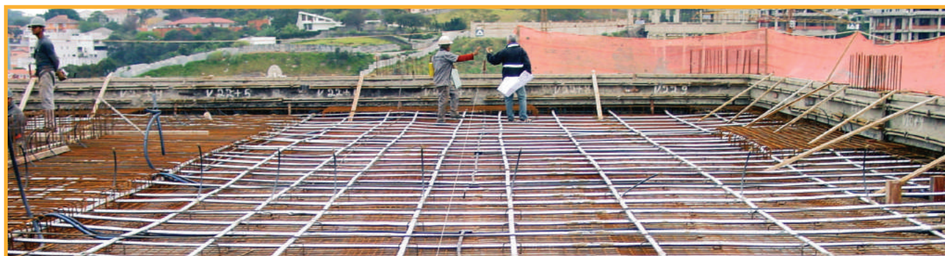
Imagem 01: Protensão do Edifício Igarassu, São Paulo - SP
