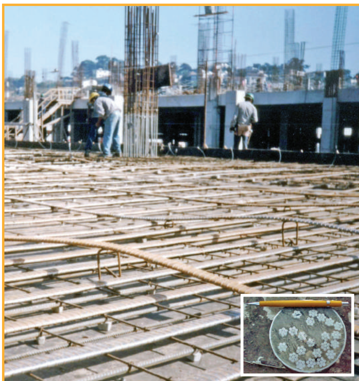
Imagem 09: Execução de laje com protensão aderente. No detalhe, seção transversal de um corpo de prova de ensaio com aderência.
