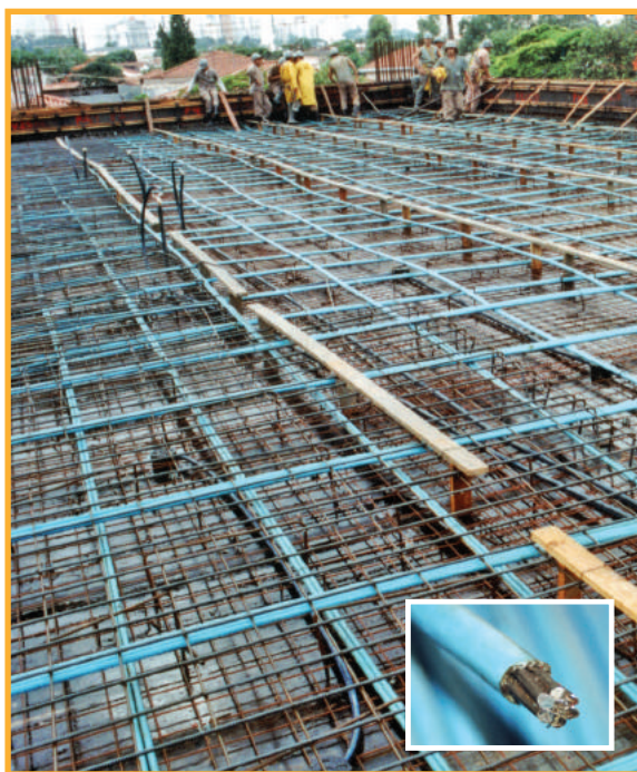
Imagem 11: Execução de laje com protensão não aderente. No detalhe, seção transversal de um cabo não aderente.
