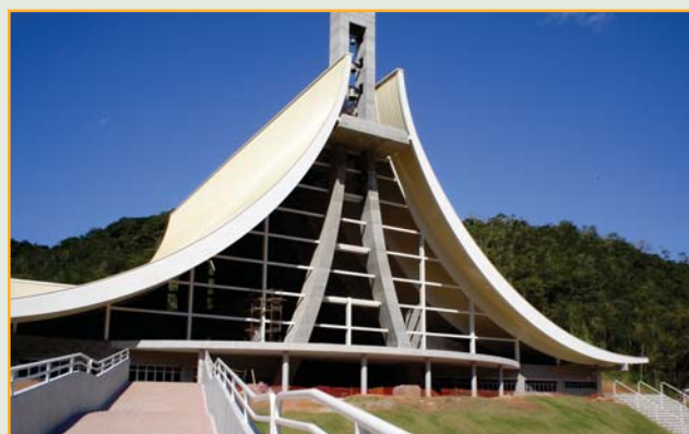
Imagem 07: Santuário Madre Paulina, Nova Trento - SC A tecnologia do concreto protendido possibilita a execução de projetos arquitetônicos e estruturais arrojados e personalizados para os mais diversos fins.
