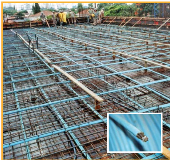
Imagem 11: Execução de laje com protensão não aderente. No detalhe, seção transversal de um cabo não aderente.
