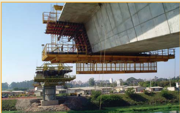
Imagem 04: Ponte Jurubatuba, São Paulo - SP Entre outras vantagens, a protensão em pontes pode permitir geometrias complexas, sobrecargas elevadas, grandes vãos, flechas reduzidas e longa vida útil às estruturas.
