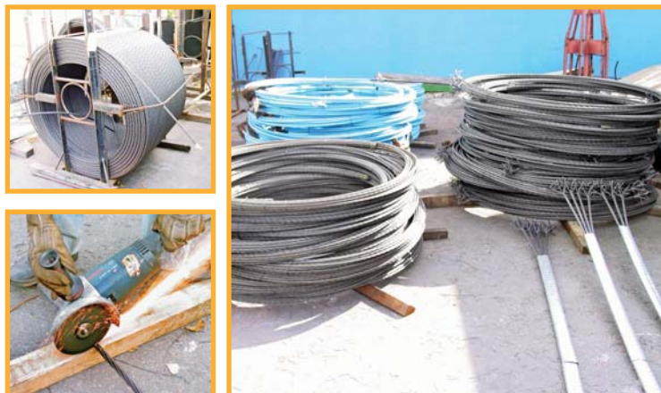
Imagem 12: Fabricação de cabos. Nos detalhes, equipamentos para o corte de cordoalhas.
