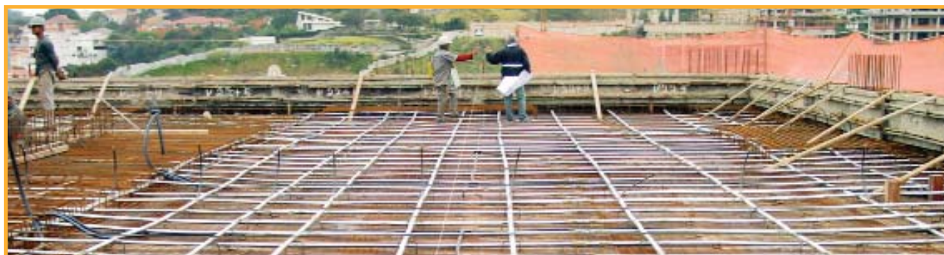
Imagem 01: Protensão do Edifício Igarassu, São Paulo - SP
