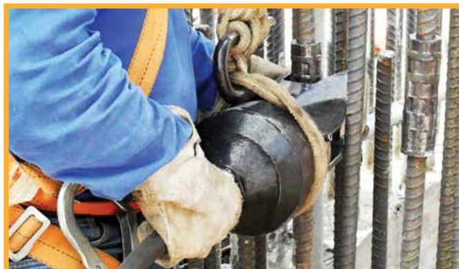
Figura 1: Uso de luvas Rudloff na armação de pilares
